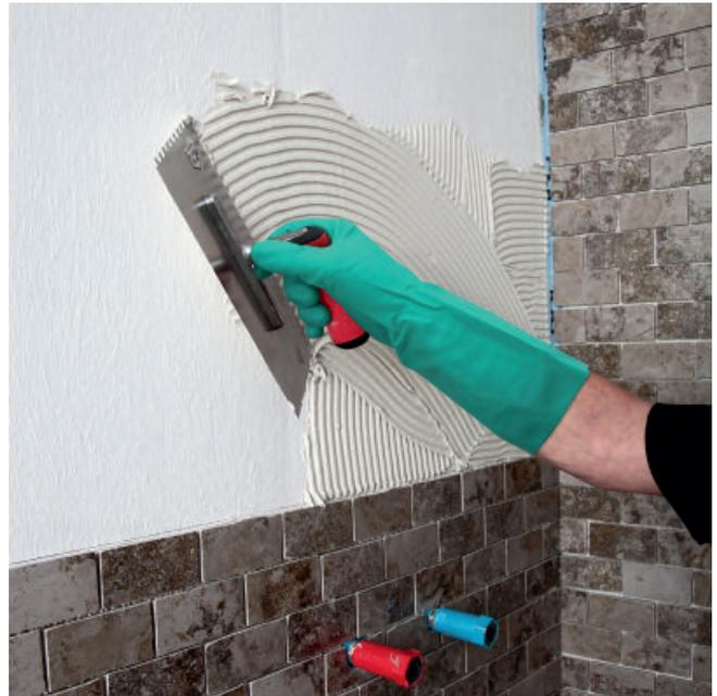
6. Nach Trocknung der PCI Lastogum-Dichtschicht können Fliesen und Platten verlegt werden.
