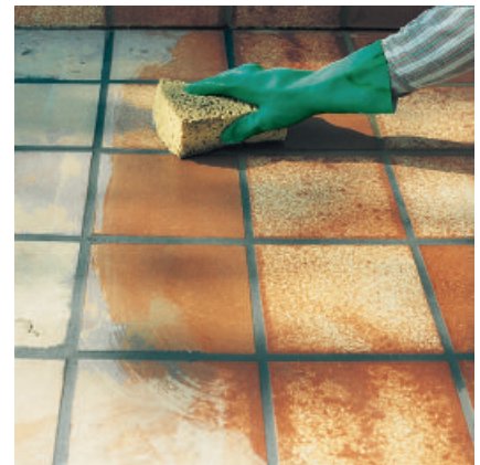
... und anschließend mit einem feuchten Schwamm nachwaschen.
