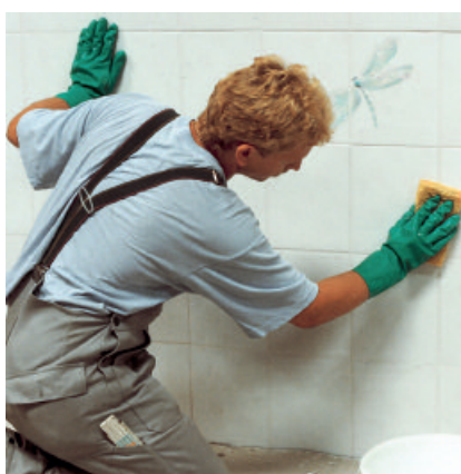
Den verbliebenen Mörtelschleier mit einem feuchten Schwamm entfernen.
