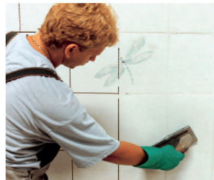
Mit PCI FT Fugengrau und PCI FT Fugenweiß können Fugen von 2 bis 8 mm Fugenbreite rissefrei verfugt werden.
