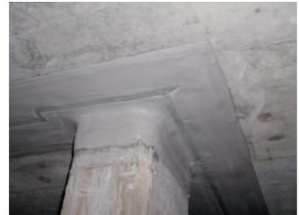
PCI Pecitape 3000 - Abdichtungsband mit PCI Barrafix EP verklebt.
