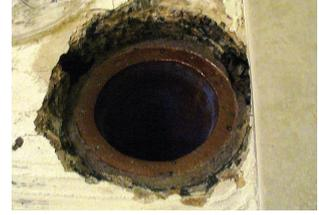
Bündig abgeschnittene Rohre
