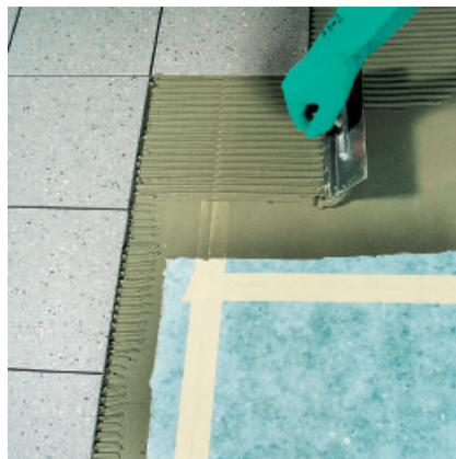
5. Anschließend keramische Beläge ohne Grundierung ...
